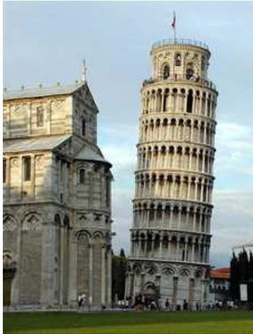
57 Meter hoch, acht Stockwerke, aus weißem Marmor. Abweichung beträgt nach 800 Jahren 4.86 Meter, auf instabilem Schwemmlanduntergrund gebaut, 1173 Beginn des Baus, 1372 vollendet, konnte 1994 durch Stahlseile und Stahlbeton stabilisiert werden, hat sich seitdem um einen halben Meter aufgerichtet.
